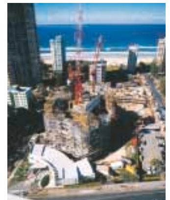
En bas: Le chantier Q1 en juillet 2003. A droite: Le chantier en décembre 2003. Photos avec l'aimable autorisation de Sunland Group.
